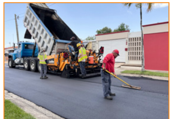
Repavimentación en Villa Fontana
