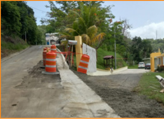
Construcción de Cunetones en la Zona Rural
