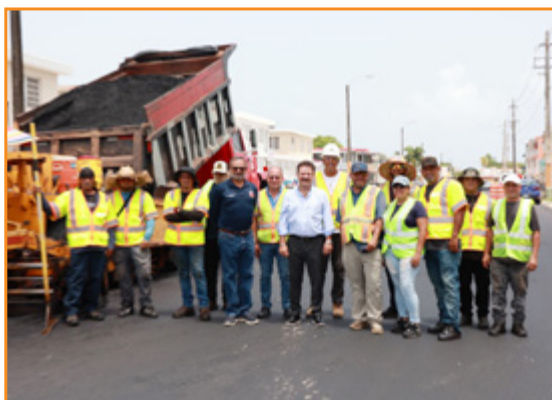
Repavimentación en Villa Carolina
