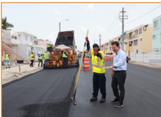
Repavimentación en Villa Carolina
